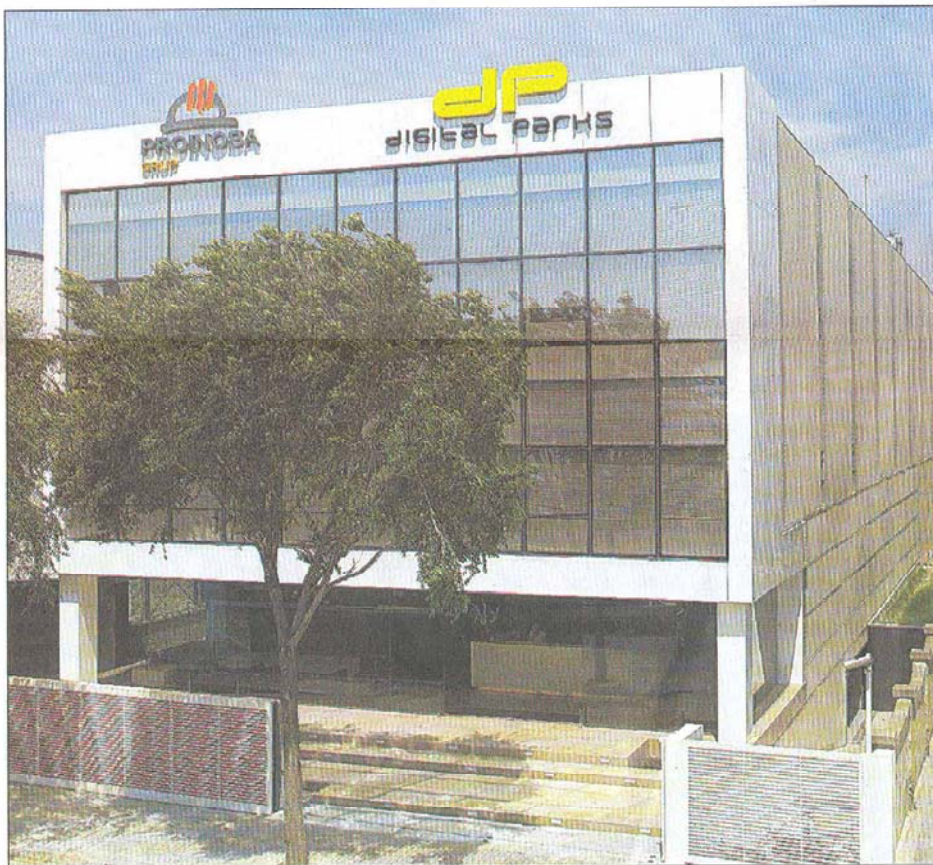
Edifici que acull el centre de dades de Digital Parks a Barcelona.
